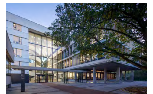
Imposante, gerenoveerde gevel aan de entree als verbinding tussen oud en nieuw
